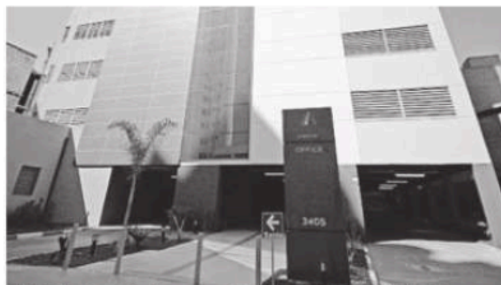
L'edificio che ospita la nuova sede della Fer-Fischer & Rechsteiner
